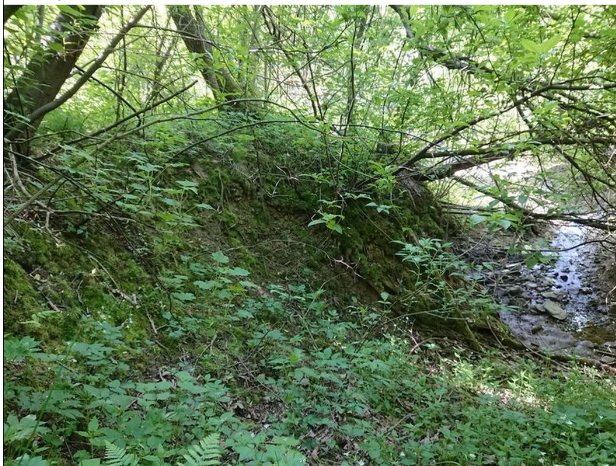
Czoło osuwiska nad potokiem.
